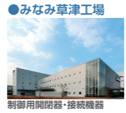
制御用開閉器・接続機器
